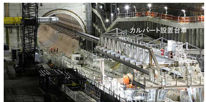
図9 カルバート設置台車トンネル内投入状況
