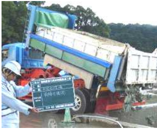
①土砂ピットへの排土
