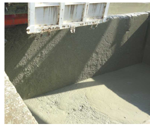
②土砂ピット内(泡なし)
