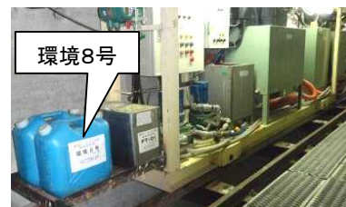
写真-3 後方台車の起泡材プラント
