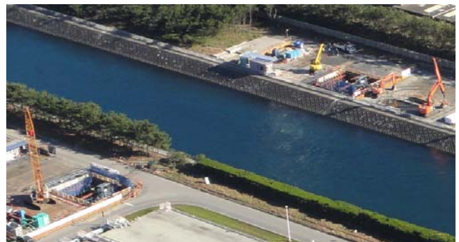
写真 1 放水路開渠横断面全景写真
