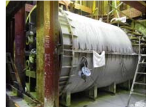
写真—2 鞘管設置状況
