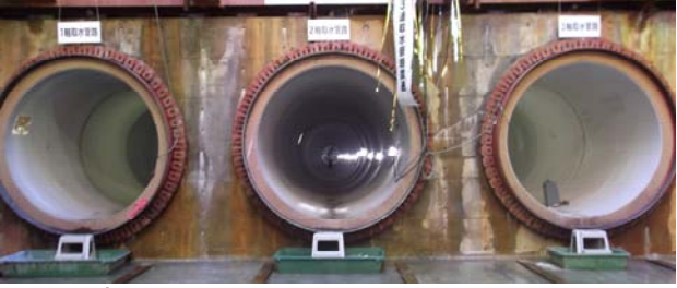
写真—4 放水路開渠横断面部施工完了全景
