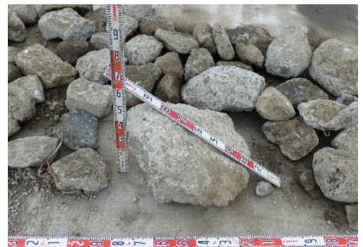
写真-3 排土中の支障物
