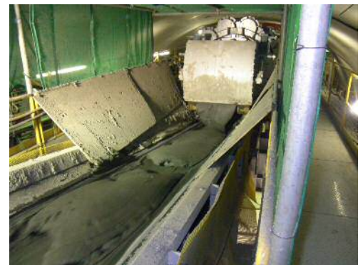
写真-2 掘削排土状況
