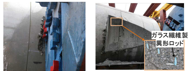
写真－2 切削開始時の状況 (No. 3)
