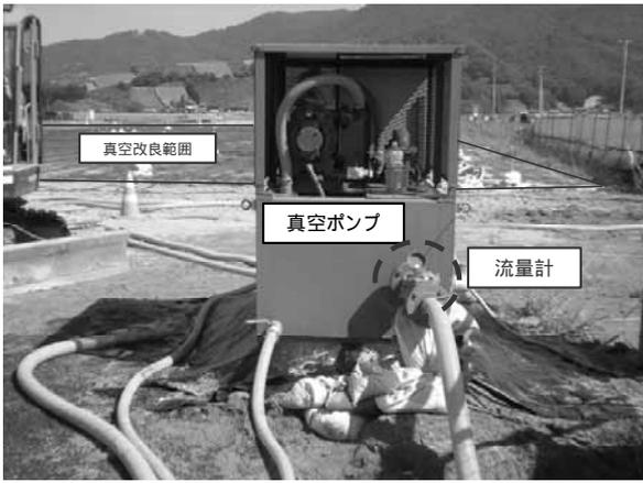
写真-1 排水量測定状況 (第3工区)
