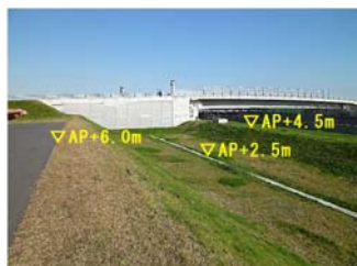
図-1 現況地盤高 (施工前状況)
