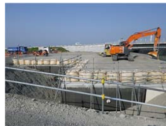
図-7 路盤材嵩上げ状況
