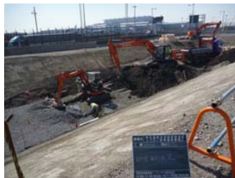
図-6 透水層設置状況
