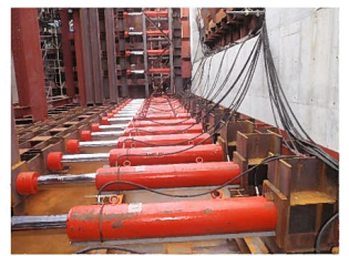
写真-2 ジャッキ配列状況
