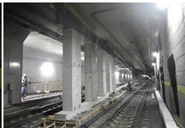
写真－5 中柱建込み完了
