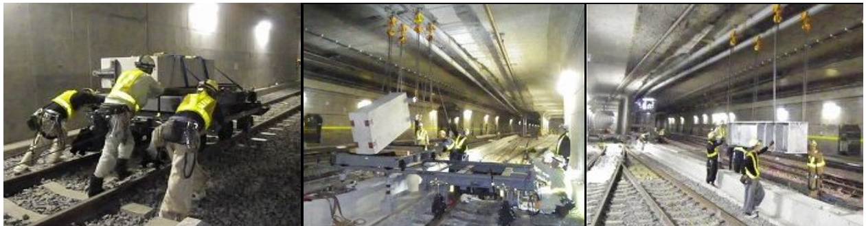
写真－1 プレキャスト中柱運搬
