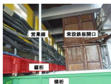
写真-2 常設鉄板開口
