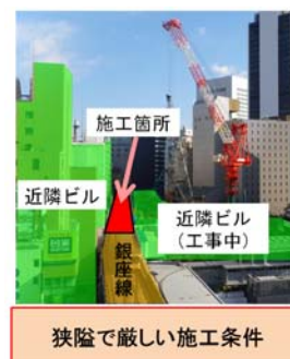
写真-1 施工環境
