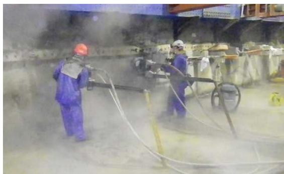
写真-2 削孔状況
