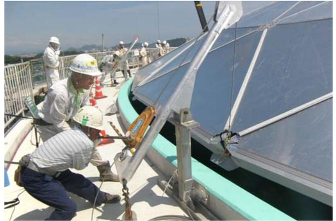
写真-3 アルミドーム屋根架設状況
