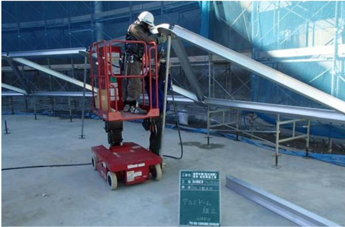
写真-2 アルミドーム屋根組立状況
