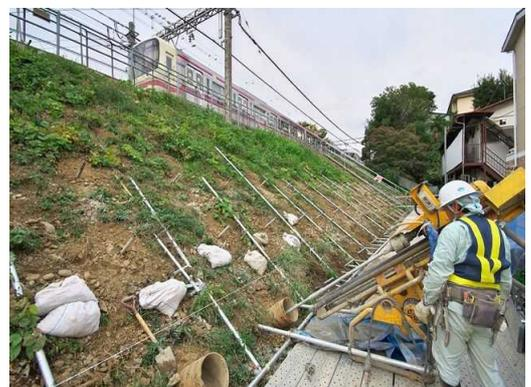
写真1 盛土浅層の玉砂利部の処理
