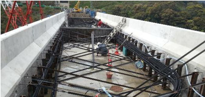
写真－7 従来のプレキャスト高欄固定方法
