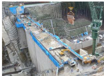
写真－1 堤体コンクリート打設状況
