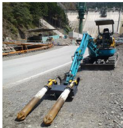
写真－4 小型コンクリート締固機
