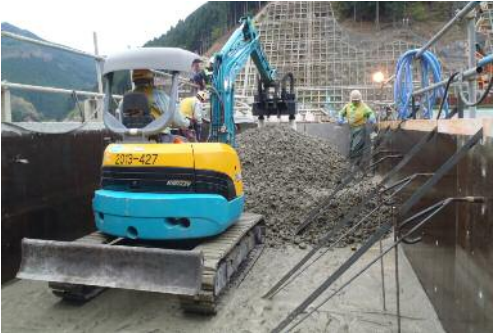
写真－5 小型コンクリート締固機による打設
