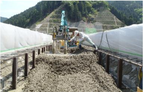
写真－9 プレキャスト高欄設置後の打設
