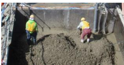
写真－3 人力による締固め
