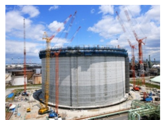
写真-4. 防液堤全景
