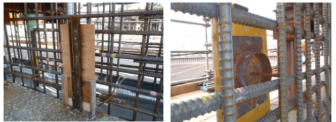
写真-3. 埋込金物付き差込み型枠ユニット
