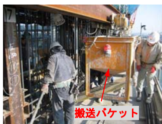
写真-1. 打設状況
