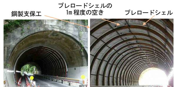
写真1 施工前の既設トンネルの状況
