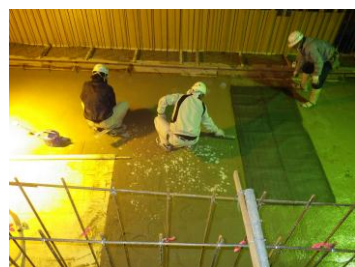
写真-2 2次仕上げ状況
