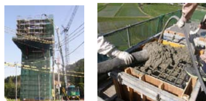
写真-1 模擬打設状況
