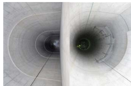
写真-1 ケーソン内部の構築状況
