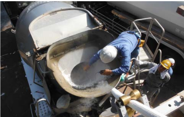
写真-2 コンクリート温度測定状況
