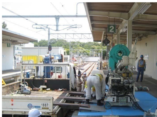
写真-3 一般用架台の搬入試験
