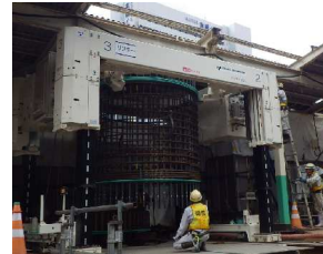
図-6 リフターおよびクレーンによる鉄筋籠建込状況
