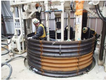
図-3 防護ライナー施工状況
