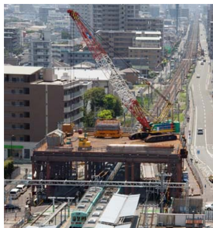
写真1 仮設構台(大牟田方)
