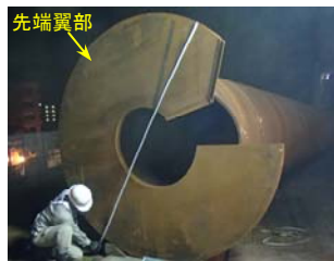
写真 2 回転圧入鋼管杭
