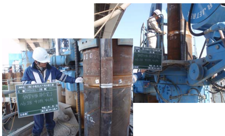
図5 接合状況・品質管理状況写真
