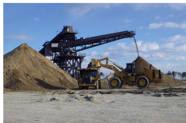
写真-2 旋回コンベヤによる撒き出し状況
