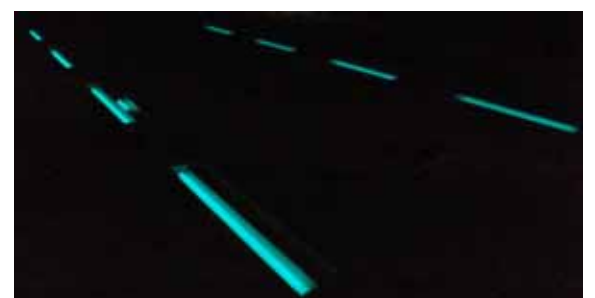
写真-3 安全通路における発光(基本タイプ)
