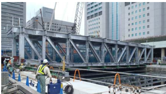
写真-1 横曳き状況
