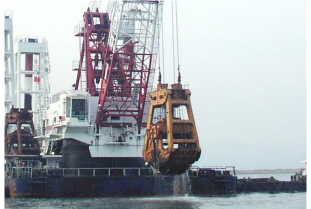
図-1 グラブ浚渫
