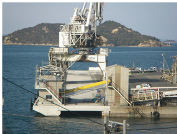
写真-1 本船バース完成 西側より撮影
