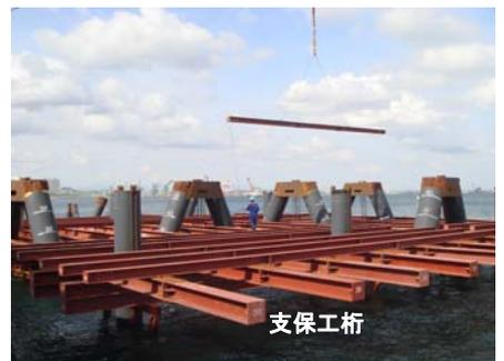
写真-3 2,3 段目支保工桁
