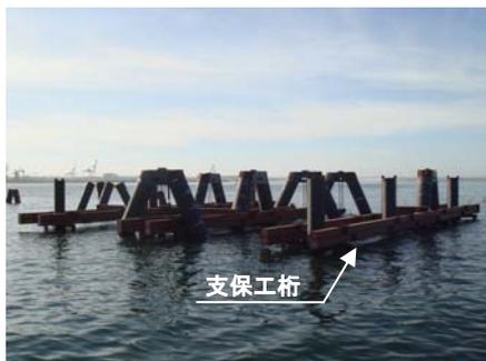
写真-2 1 段目支保工桁
