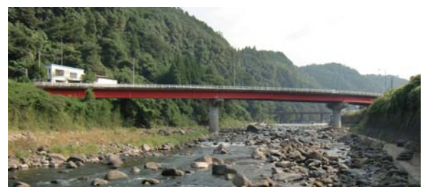
写真-1 対象橋梁全景
