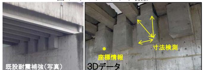
図5 落橋防止構造の出来形確認
