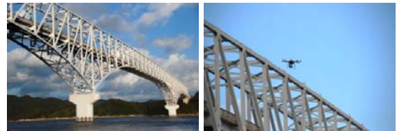
写真 2 A 橋全景と撮影状況
