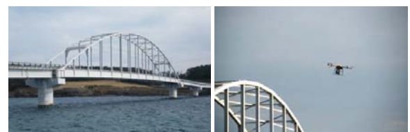
写真 3 B 橋全景と撮影状況
