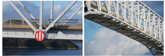
写真 4 支間中央部の画像の比較 (左; UAV, 右; 地上)
