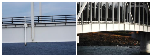
写真 6 支間中央部の画像の比較 (左; UAV, 右; 地上)
