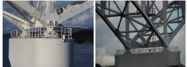
写真 5 支承部の画像の比較 (左; UAV, 右; 地上)
