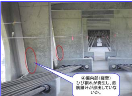
図 7：偏向部縦壁の点検
