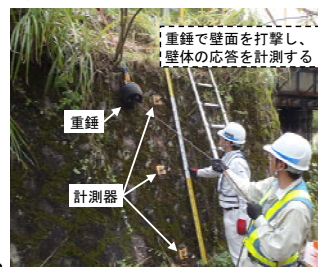
図2 衝撃振動試験の状況
