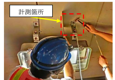
写真-1 照明灯具の計測状況
