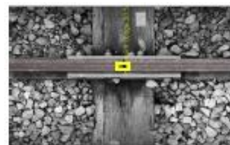
継目位置検出結果 (マーキング箇所を継目と認識)
