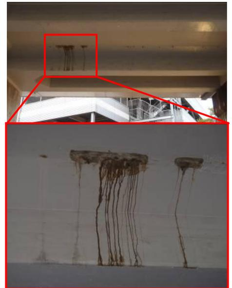
写真-1 剥離及び漏水
