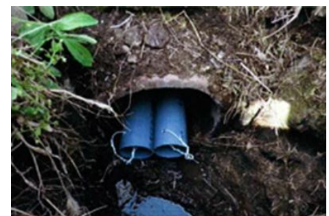
写真2. 従来の応急措置工法
