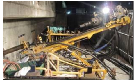
図-3 ロータスアンカー掘削機
