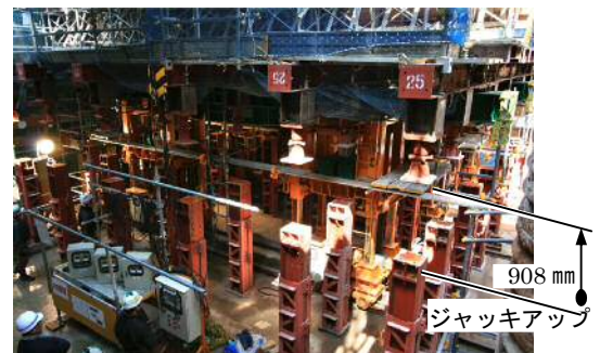
写真-3 ジャッキアップ後
