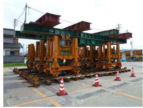
写真-1 試験施工
