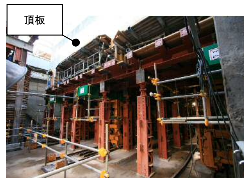
写真-2 ジャッキアップ前
