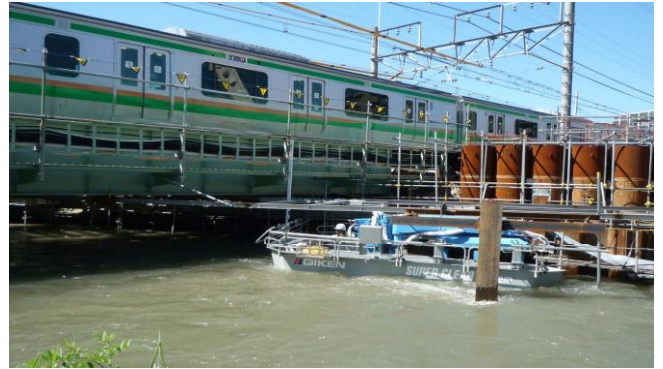
写真-4 超低空頭パイラー設置状況
