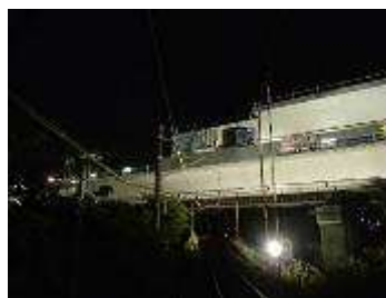
下り線本桁上を縦取り
