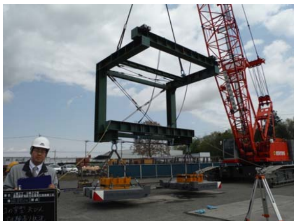
写真-2 試験施工状況
