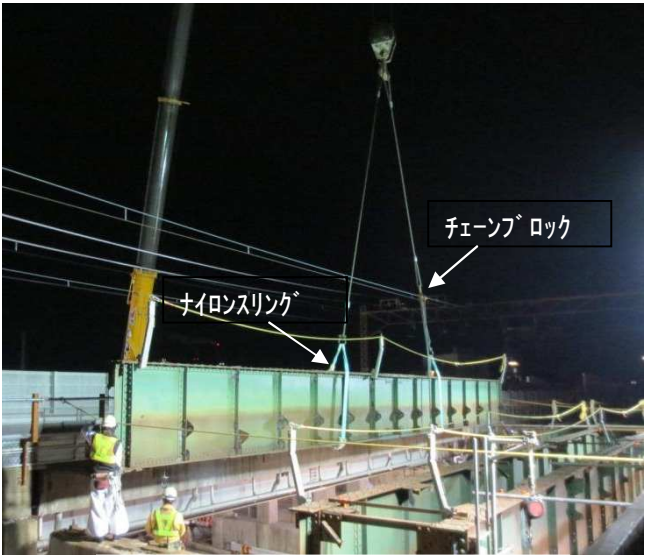
図3. ナイロンスリングによる吊状況
