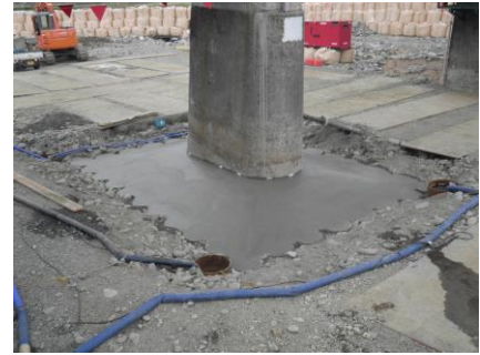
図 5 根固工（完了状況）
