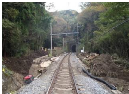
写真-2 応急復旧状況
