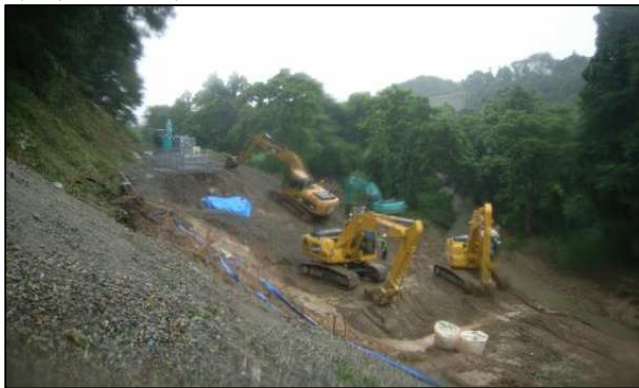
図4 セメント改良の様子
