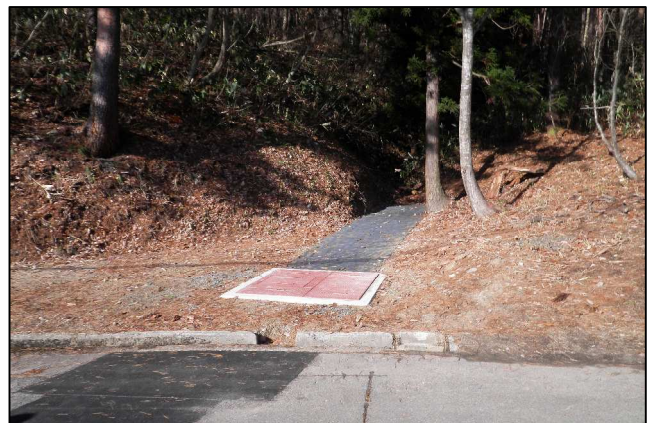
図6 集水ます設置後の様子
