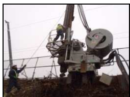
図-11 パイルオーガ施工状況
