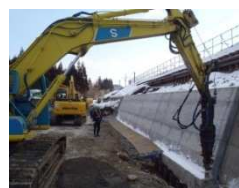
図-13 鋼矢板打設状況
