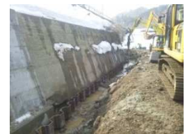
図-14 鋼矢板打設完了
