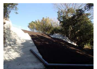
写真-8 復旧完了 (下部)
