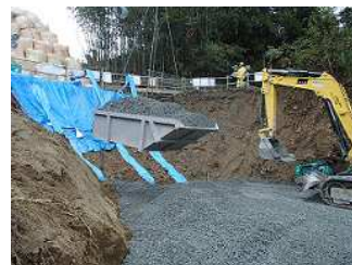
写真-6 盛土材投入状況
