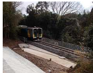
写真-7 復旧完了 (上部)
