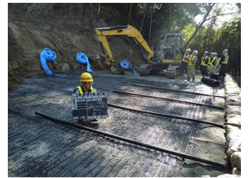
写真-5 面状補強と水抜きパイプ
