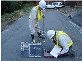
小型 FWD 試験状況
